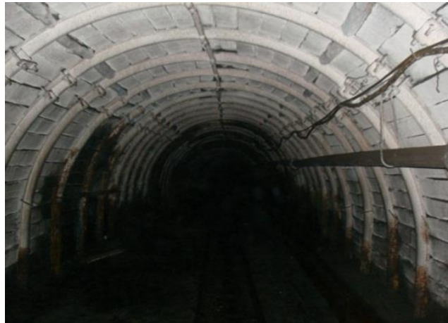
شکل ۵-۱- تونل اصلی اندود شده با آب آهک
